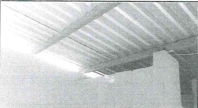
Foto 3: Mantenimiento de baños, pintura, limpieza y mantenimiento de puertas.
